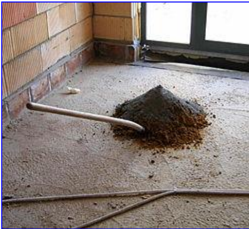
Ручне приготування пісково-цементної суміші
